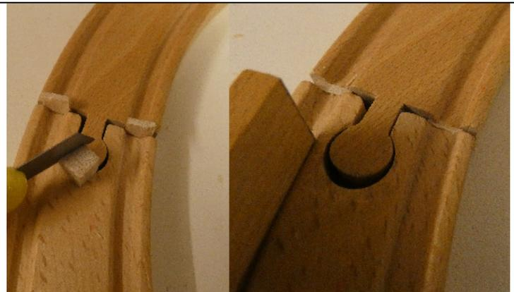
Remplir l'espace entre rails Brio avec des blocs de balsa – ne pas mettre de colle
